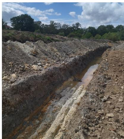
Fouille de la clef d'étanchéité de la contre digue (02/08/2023)
