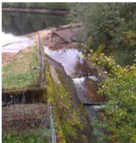
Pertuis au niveau du déversoir de crue
