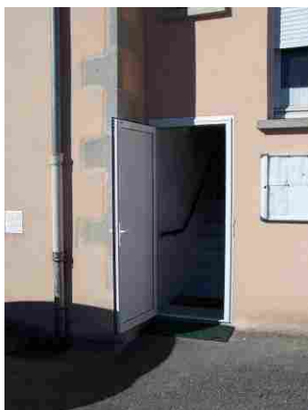
L'entrée et le couloir de la Mairie
