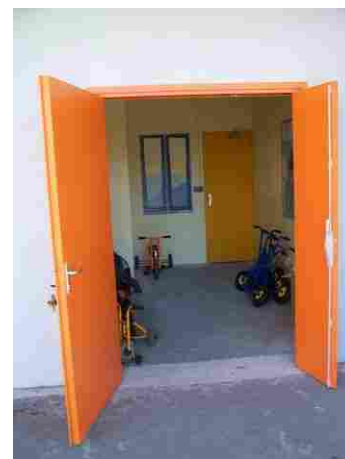
L'accès à la salle de motricité
