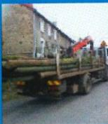
**Dépose lignes des électriques et téléphonique dans le bourg** : La société SOCALEC de Gouzou (Creuse), sous la direction du SDEC, a procédé à la dépose des lignes et des poteaux électriques comme suite à l'enfouissement de l'alimentation des maisons et de l'éclairage public.
